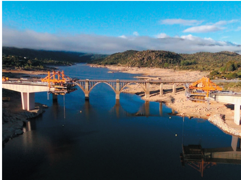
Ejecución del vano central.
