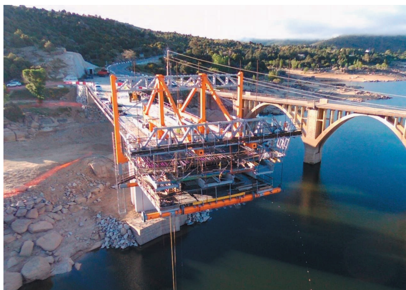
Carro de avance en voladizo.
