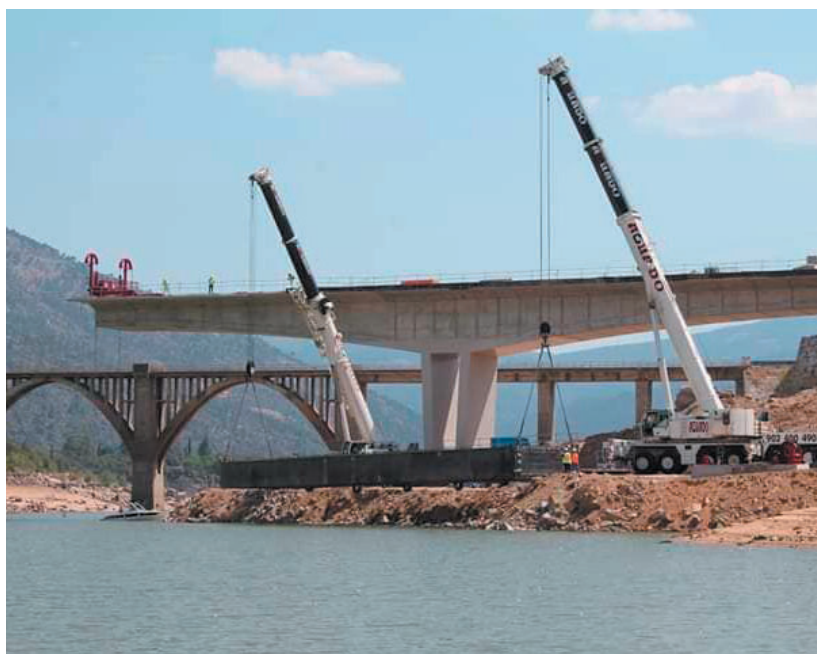
Botadura de la pieza central sobre el embalse.
