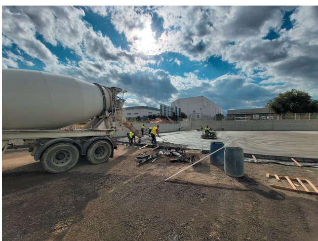
Solera de hormigón con aditivo ENAHTEC. Puesta en obra.
